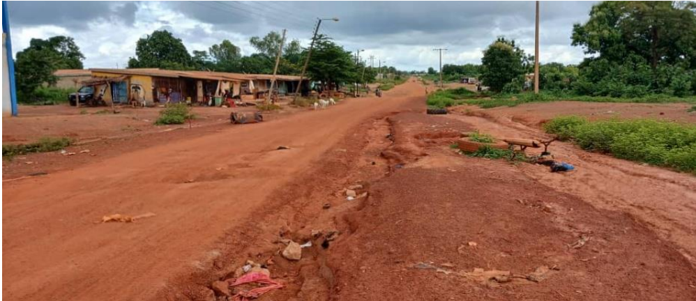
Photo 1. Voirie de M'Bengué – Korhogo
