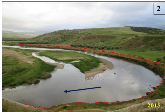
2- L'érosion sur la rive gauche de Oued Sebou, à l'ouest du douar Megra
