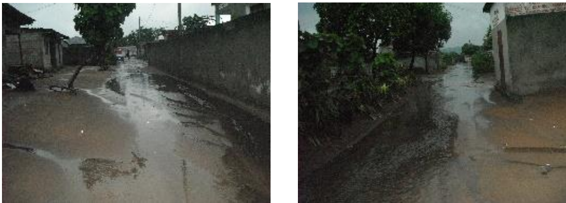
Figure 1 : Ecoulement des eaux dans une rue après une forte pluie
