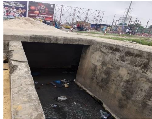
Image 2 : illustration des canaux qui récoltent des eaux usées des ménages et les jettent dans la nature (Rivière KALAMU). Au niveau de l'avenue des universités en date 23 Avril 2026
