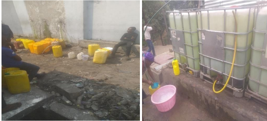
Figure 6. Etat des lieux de forages Source : Enquête sur terrain 2023
