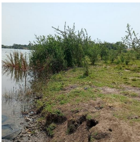
Photo1 : Érosion côtière du chenal Gbaga
