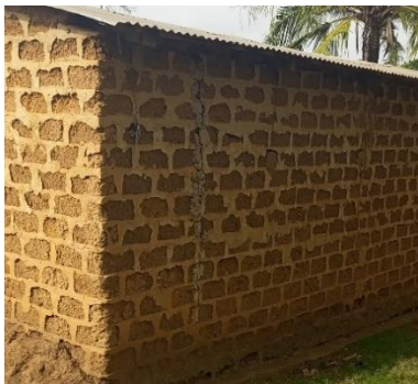
Photo 3 : Modèle amélioré de maison avec des briques de terre et les jointures en ciment
