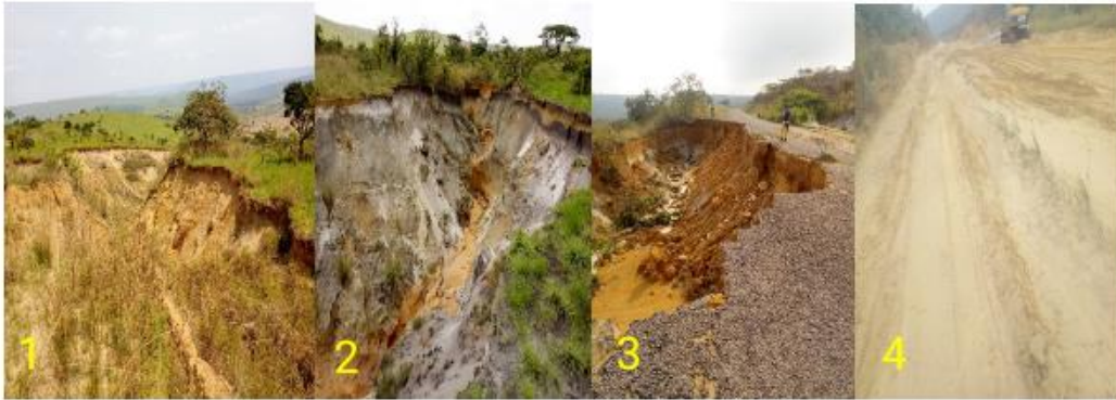
Photo 1 : Ravin 1 à 18 mètres de la chaussée ; Photo 2 : Ravin 2 à 70 mètres de la chaussée ; Photo 3 : Ravin 3 coupant plus de la moitié de la chaussée ; Photo 4 : Ensablement sur une grande partie de la chaussée
