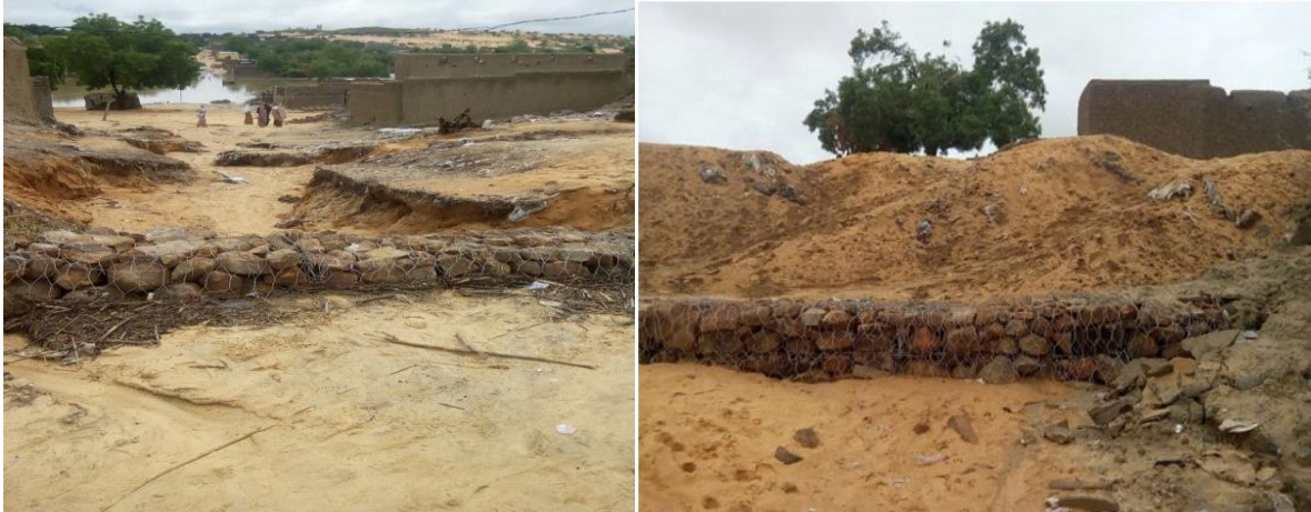
Photo 12: ouvrages construits sur les bras les plus puissants de Tapkin Balangandé Source : Sotie de terrain, 2019
