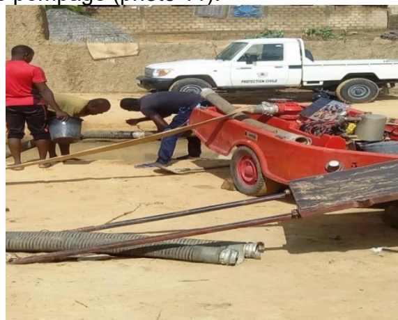
Photo 11 : machine de pompage utilisé pour vidage de l'eau.
