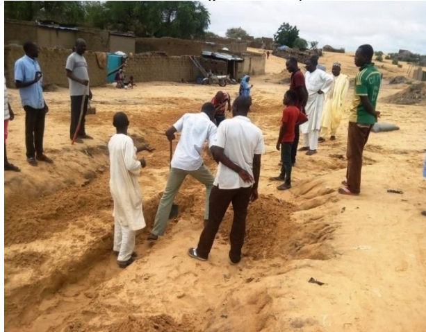
Photo 10 : canal conçu pour évacuer l'eau hors de la ville
