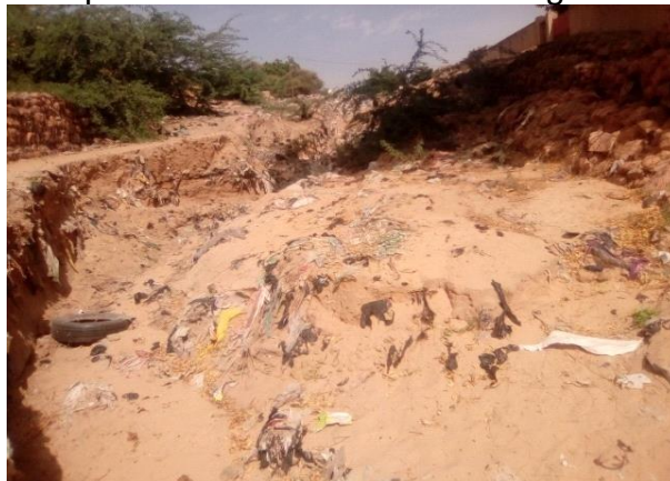
Photo 2 : incision des berges traitées en pierre sèches et transport de sédiments
