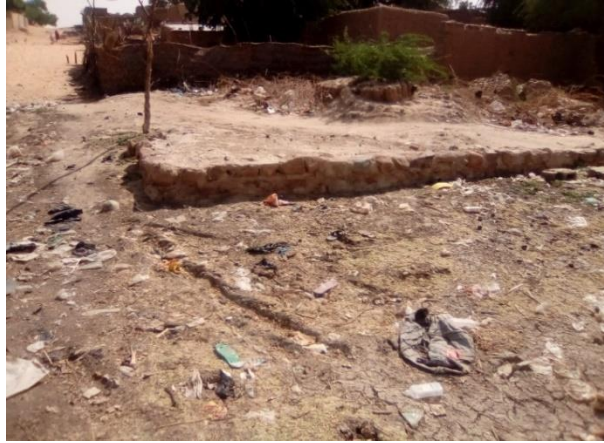
Photo 9 : construction de muret
