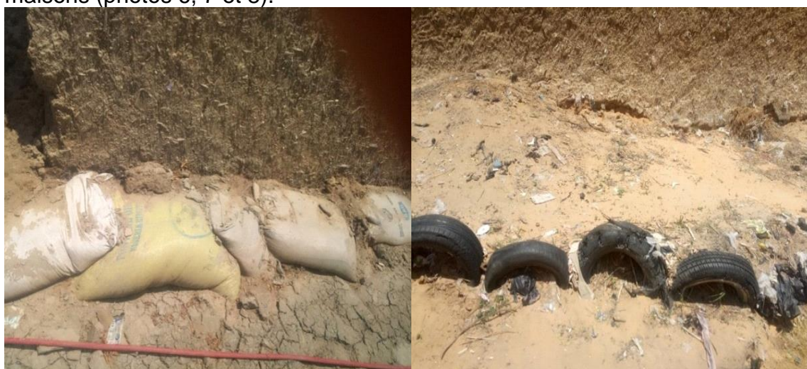
Photo 6 : installation des sacs de sable Photo 7 : installation des pneus
